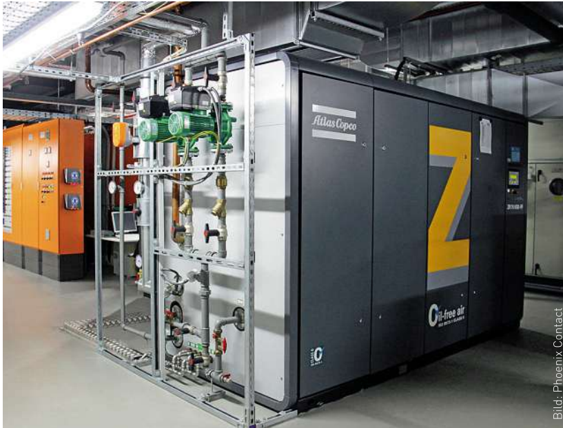
Bild 2: Der ölfreie Druckluftverdichter wird mit einer Auslastung von 60 bis 80 % betrieben, weil er bei dieser Arbeitslast die höchste Energieeffizienz aufweist.
